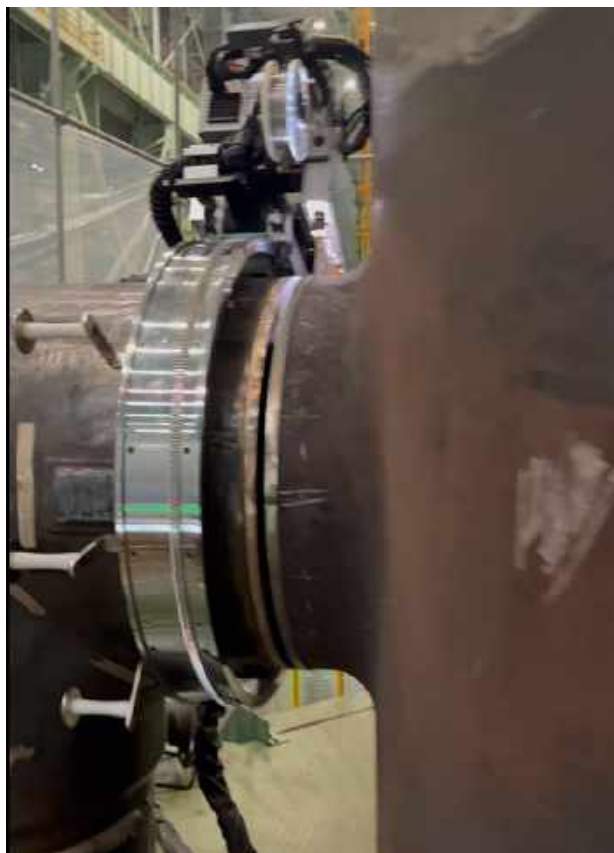
核容器接管窄间隙 TIG 焊接系统
